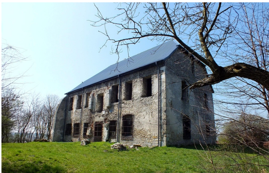
Fot. Kinga Juszcak. Widok dworu od strony północnwschodniej.
