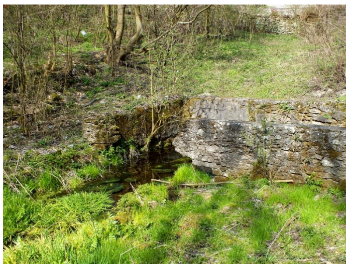
Fot. Kinga Juszczak. Źródło wypływające ze zniszczonego ogrodzenia
