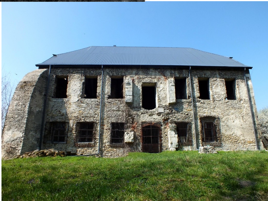
Fot. Kinga Juszczak. Widok na ścianę wschodnią dworu w Szańcu obecnie.
